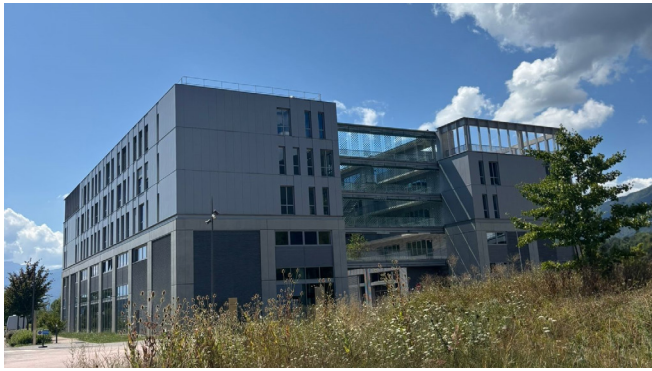
Site de Savoie Technolac
